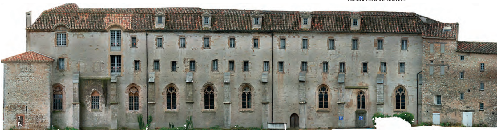
Facade nord du couvent
