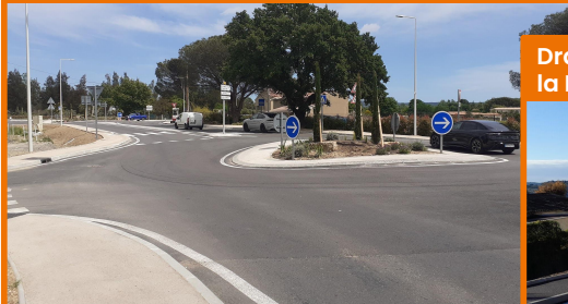
Grimaud : Aménagement du giratoire avec la RD 61.
