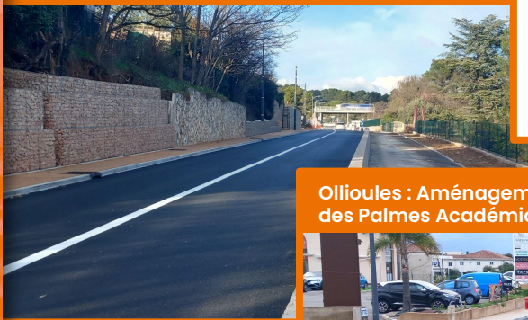
Brignoles : Requalification entre le giratoire Piégros et le quartier de Paris
