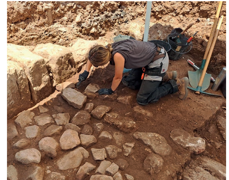
fig. 2 - Parement en grand appareil du rempart en cours de dégagement
