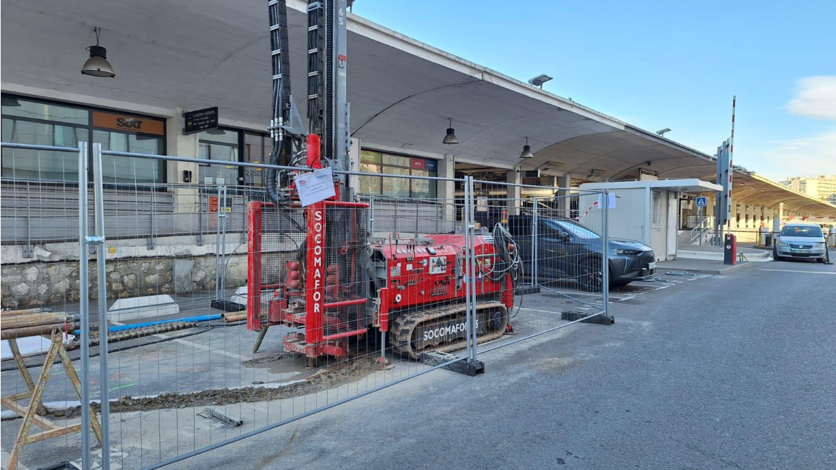
Travaux de sondages géotechniques, Marseille Saint Charles
