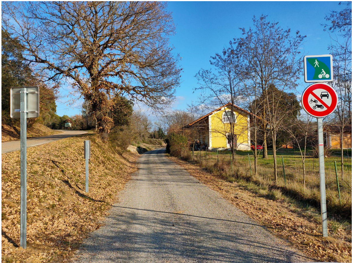
Raccordement avec l'EV8 existant au niveau de l'ancienne gare de Saint-Martin-de-Pallières
